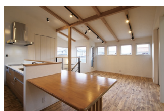
小さな窓を多数配置して、日射取得と視線の遮断をバランスよく両立
