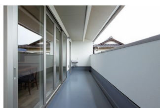
スリット窓を採用、ベランダの囲いを高めに設定して外部からの気になる視線に配慮
